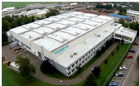
Výrobní závod a logistické centrum ve Znojmě
